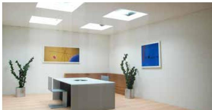
Pozzetto ad alta riflessione - Fattore di luce diurna interno massimo circa 8%
